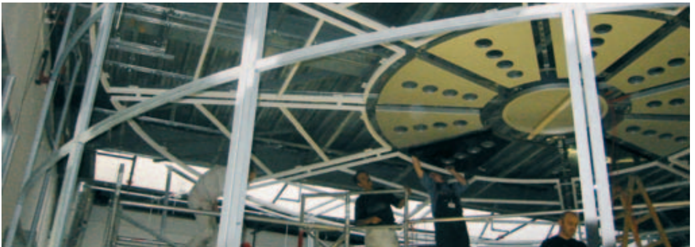
Jemoli Zürich Sportabteilung 4. OG – Montage Decken- und Wandkonstruktion für Spanndecken und Beamerleinwand im Lichthof.
