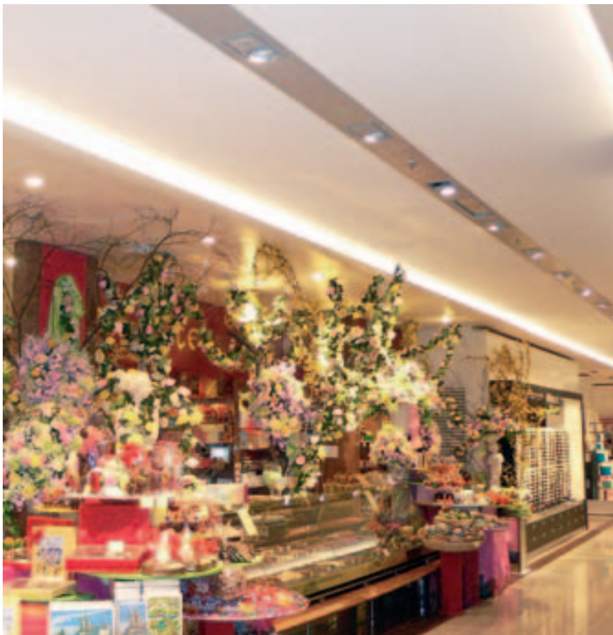
Jelmoli Zürich – Neu gestaltete Deckenpartie mit indirekter Beleuchtung über Gehwegen im Erdgeschoss mit Ladenteil Teuscher.
