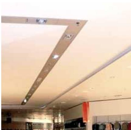
Spanndecke mit Installations-Kanal sowie Abschlussleuchten-Kanal als Indirekt-Beleuchtung
