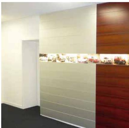
Wandverkleidung mit Aluminium- und Holz-Paneeelen inkl. Einschiebe-Kassetten mit Autobildern
