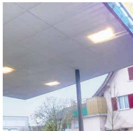
Vordach über Autoausstellung: windgesicherte Streckmetall-Decke
