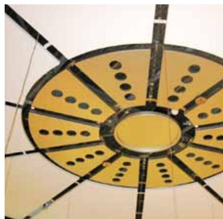
Decken-Segmente aus natureloxiertem Aluminium-Blech mit integrierten Stromschiennen
