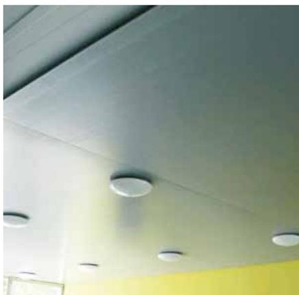
Decken-Spiegel eingefasst mit Abschlussprofil aus Holz (Akustik-Decke)
