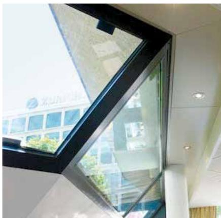
Quadratplatten-Decke aus Gips mit metallener Abschluss-Stirne zum Fensterbereich
