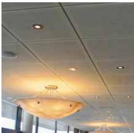
Quadratplatten-Decke aus Gips mit einem Metallraster von 15 mm
