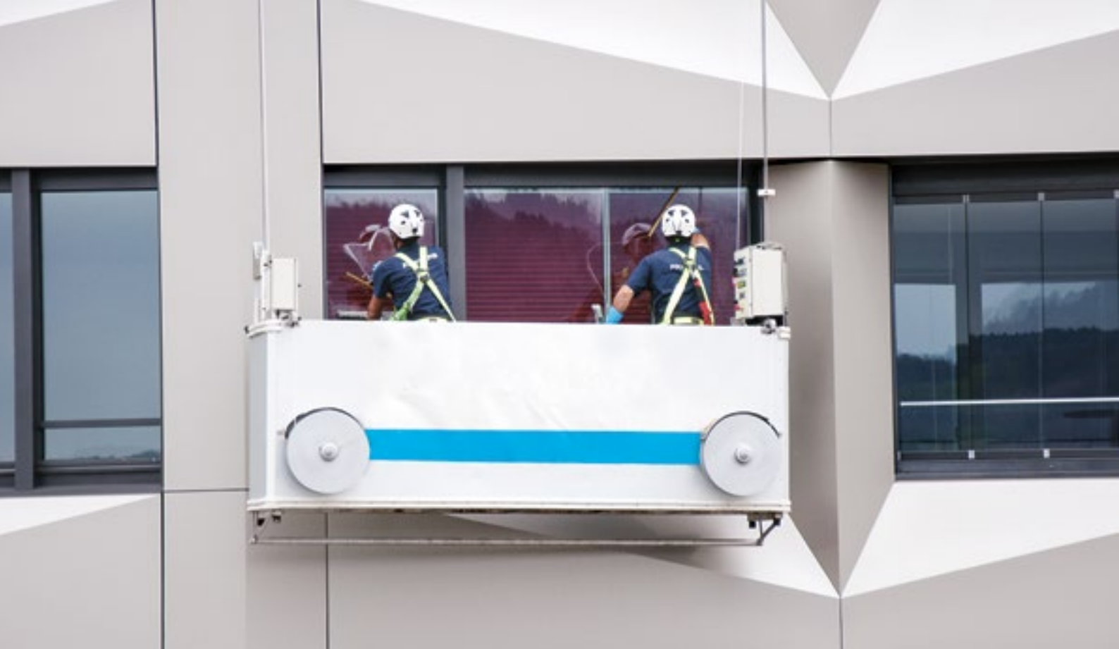
Poly-Rapid AG: Spezialisiert auf Einsätze in schwindelnder Höhe wie beim Limmat Tower in Dietikon.
