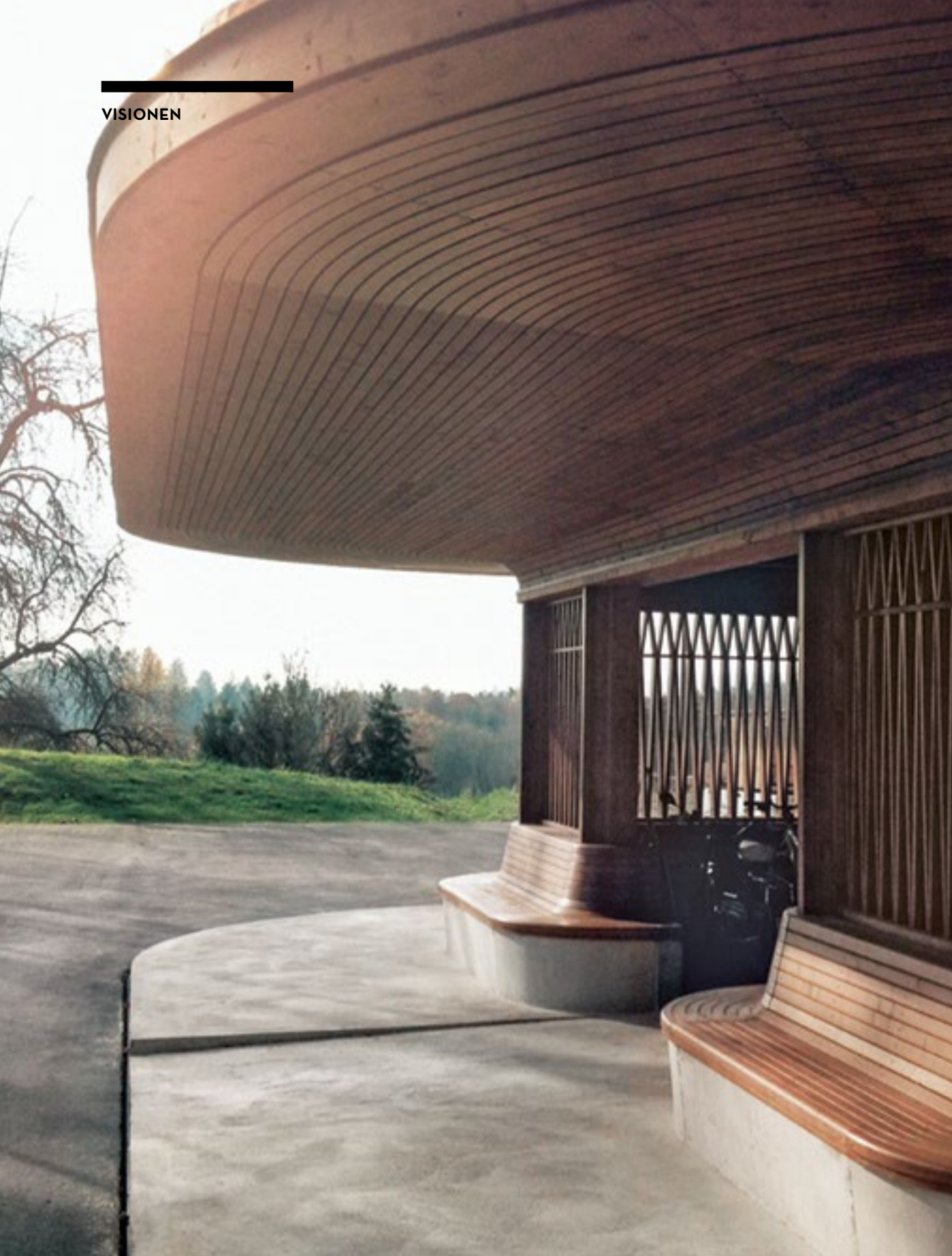
BAUR Holzbau AG: Der Holzbau geht mit der Zeit – und beweist Grösse.
