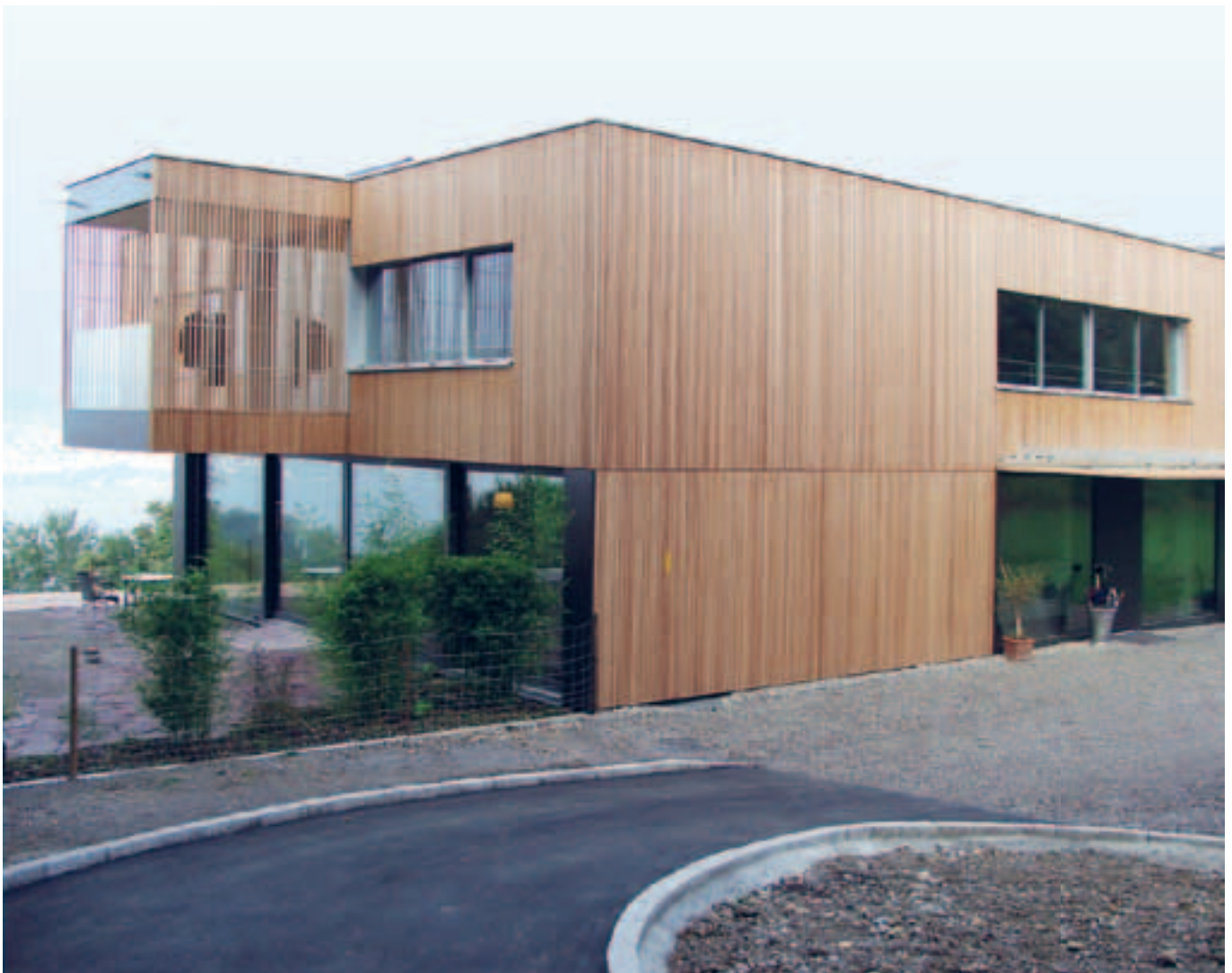
Unkonventioneller Fassadenbau in Erlenbach am Zürichsee
