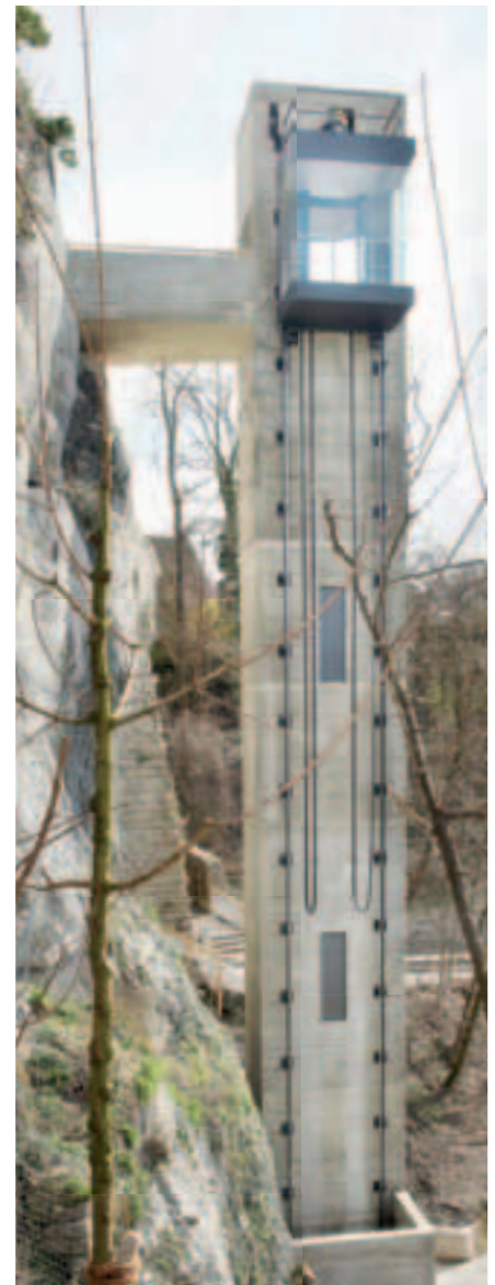
Aufzug Schloss Laufen am Rheinfall
